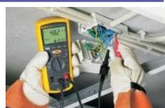
Test kabeláže v malé rozvodné skříni – vše v jednom bodě
